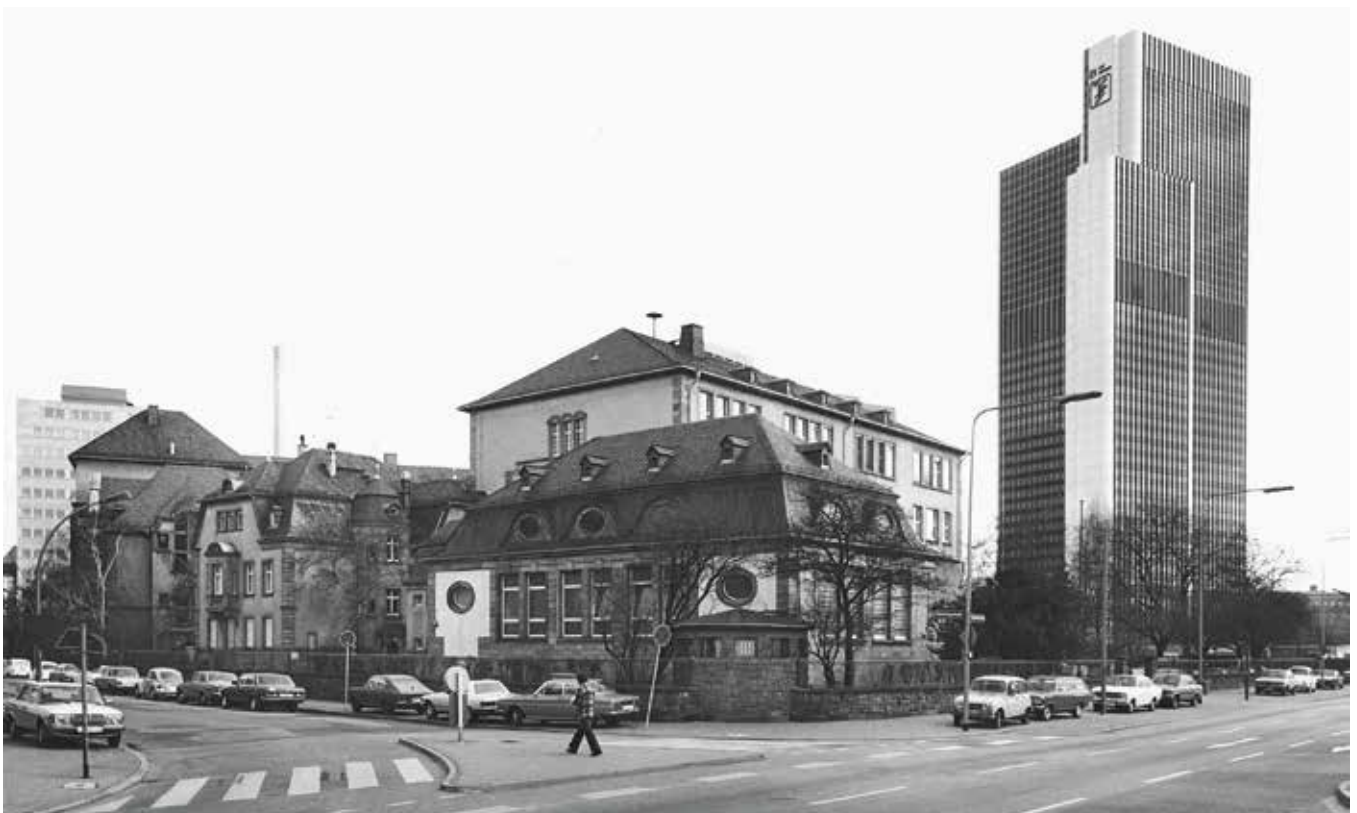
Blick auf die Varrentrappstr. 34-38 an der Ecke Theodor-Hemp-Allee im Frankfurter Westend (1979)
